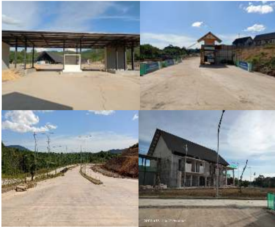
Gambar 4. PLBN Jagoi Babang Sedang Dalam Proses Pembangunan
